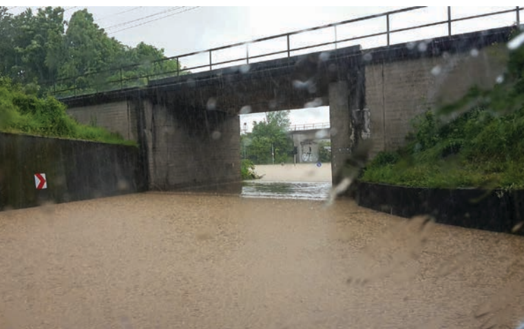
Hochwassersituation im Mai 2016 in Bad Friedrichshall.
