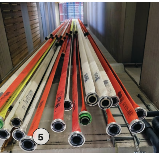
Der Blick hinauf in den 25 m hohen Schlauchturm.
