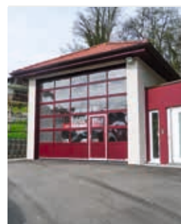
Anbauten der Feuerwehr Möckmühl
