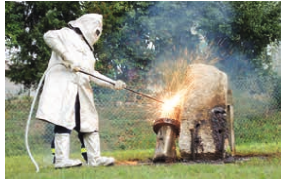
Oben: Der Kranausleger wurde zur Bergung durchgeschnitten.
