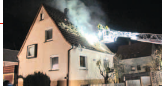
Öffnen der Dachhaut mit Unterstützung der Drehleiter aus Lauffen.
