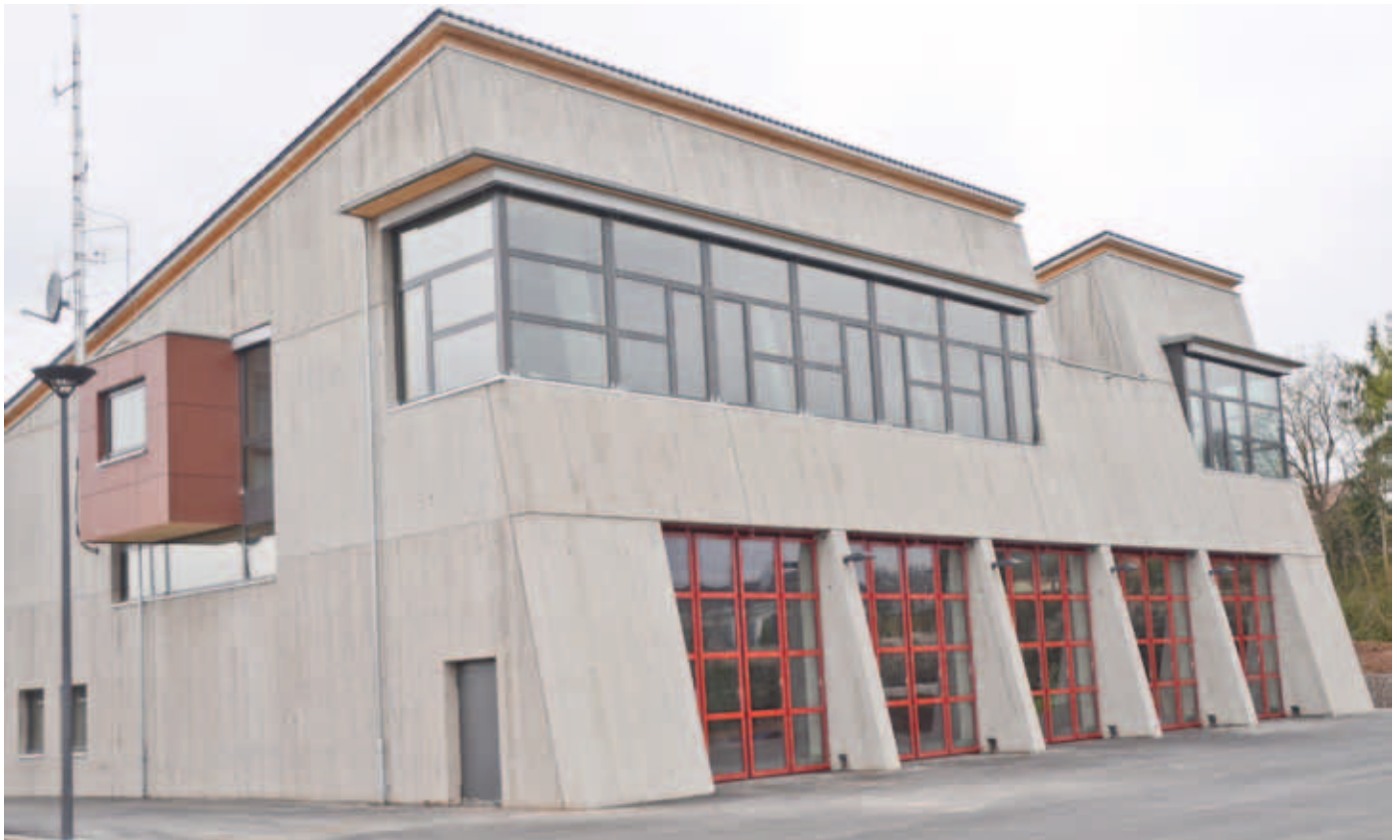
Das neue Feuerwehrhaus in Beilstein auf der Harthöhe.
