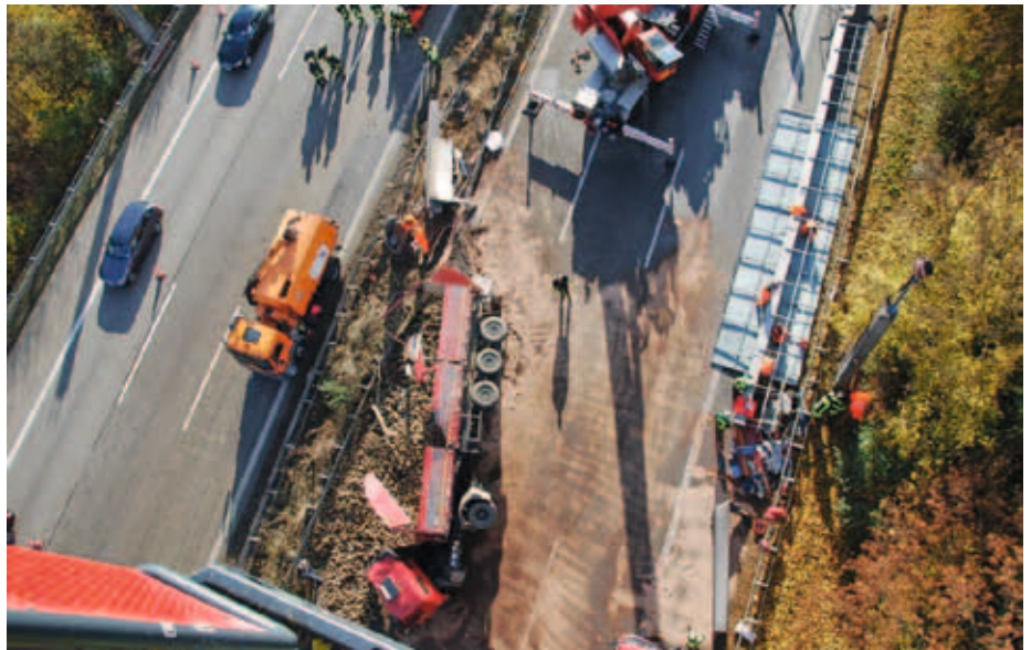
Folgen einer Reifenpanne: Auf der BAB A6 wurden Schilderbrücken zerstört.
