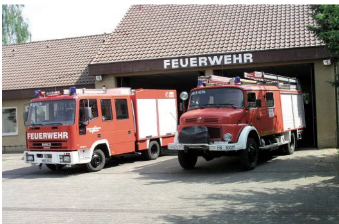
Feuerwehrhaus der Abteilung Horkheim
